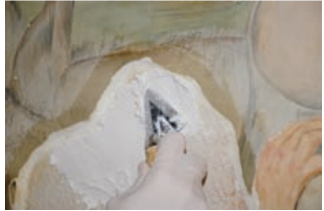
Fig. 51. Reintegración de morteros ( Huida ).
