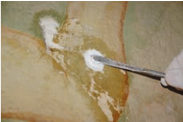
Fig. 52. Reintegración de morteros ( Soldados ).
