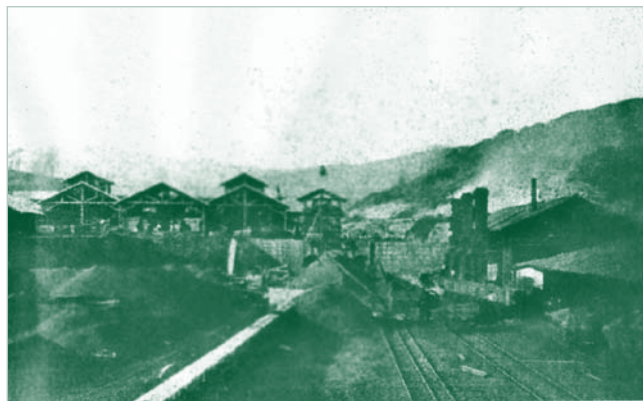
Fig. 2.- Vista de los hornos de calcinación.
