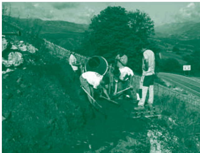
Llenando la hormigonera.
