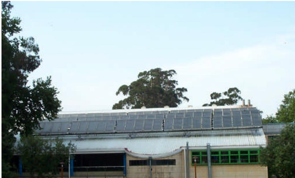
Figura 6.6. Instalación solar térmica en complejo polideportivo del ayuntamiento de El Astillero.
