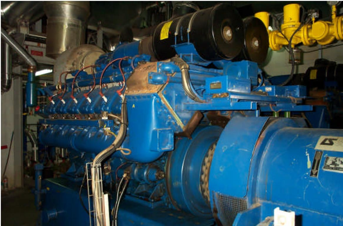
Figura 4.1. Instalación de cogeneración en Poenercan, S.L.
