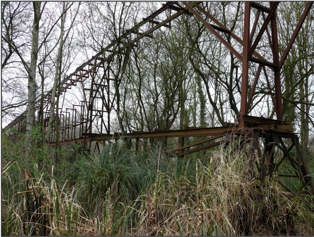
Fotografía 19. Estructura portante del canalón de fangos de la marisma Liaño-Solía.
