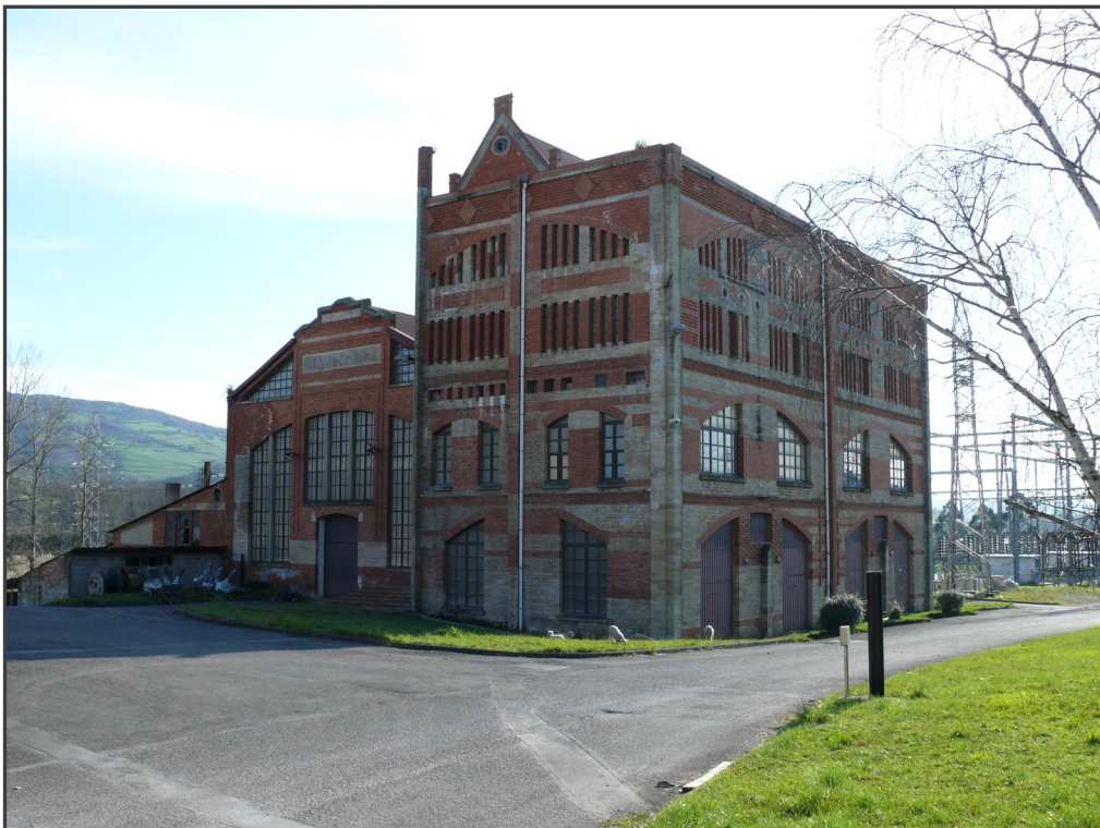
Fotografía 25. Central térmica y subestación eléctrica de Electra de Viesgo.
