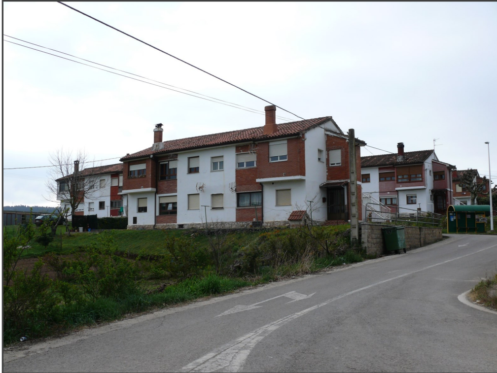
Fotografía 18. Barrio Santa Bárbara para trabajadores de Orconera.
