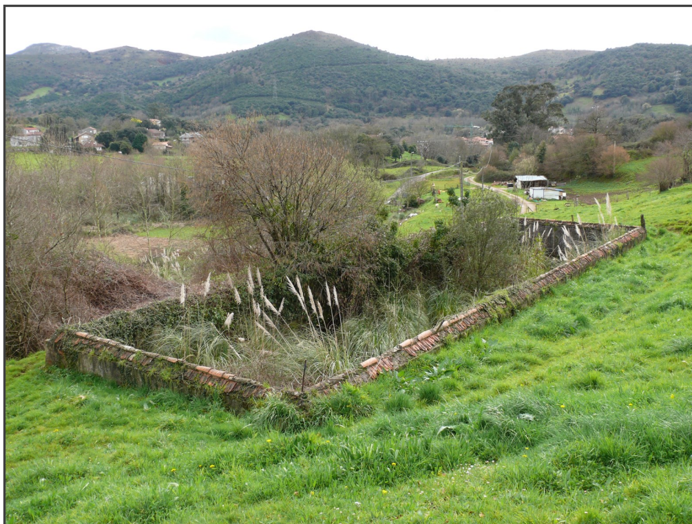
Fotografía 12. Depósito de agua para las locomotoras de vapor
