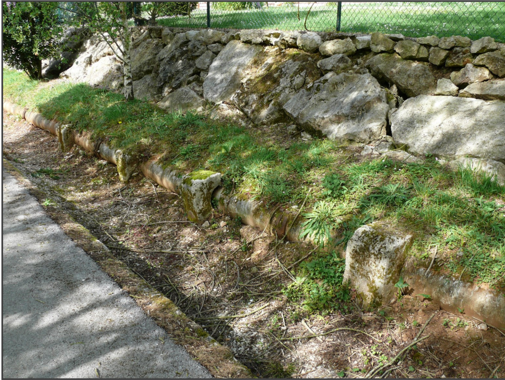
Fotografía 7. Tubería de agua para la planta de concentración de Obregón
