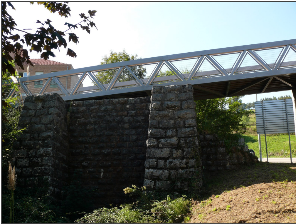
Fotografía 10. Estribo del puente sobre la carretera general.
