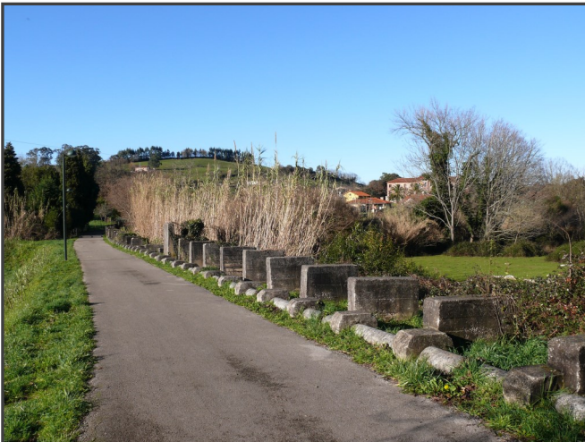
Fotografía 8. Bases del canalón de fangos de Obregón a Solía.
