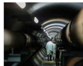
El túnel bajo la vía por la que llegan a la depuradora las aguas
